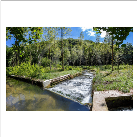
Isère (38), commune de Saint-Blaise-du-Buis, Le Rivier, Espace naturel sensible de l'Isère, étang de Cote Manin, passe à poissons construite pour assurer la continuité écologique de la rivière La Fure // Isère (38), Saint-Blaise-du-Buis, Le Rivier, sensitive natural area of the Isere, pond Cote Manin, fishway built to ensure the ecological continuity of the river Fure
