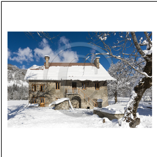
Hautes Alpes, 05, Vallée du Champsaur, Vallée de Champoléon, Ecogîte Le Passage des Sarrasins, Au coeur des hautes alpes, a 1200 mètres d'altitude, aux portes du parc national des ecrins. 2 gîtes ruraux dans ancienne ferme entièrement rénovée avec des matériaux écologiques. chauffage central au bois. // Hautes Alpes, 05, Champsaur Valley, Valley Champoléon, Ecogîte The Passage of the Saracens, the heart of the high Alps, at 1200 meters altitude, near the Ecrins National Park. 2 gites in former farm renovated with ecological materials. central heating with wood.
