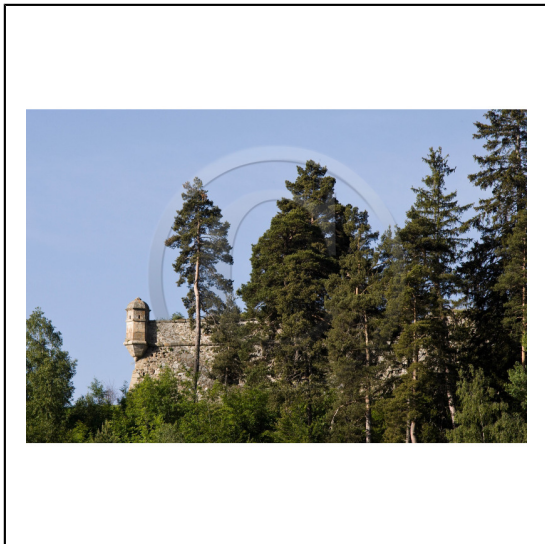
Pyrénées-Orientales, 66, Mont-Louis, Fortifications Vauban inscrites au patrimoine mondial de l'humanité UNESCO (07/2008, // Pyrénées-Orientales, 66, Mont-Louis, Vauban's fortifications on the list of Unesco world heritage sites.
