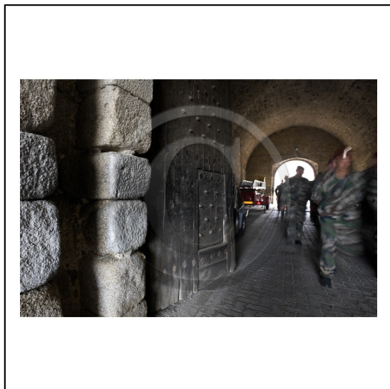
Pyrénées-Orientales, 66, Mont-Louis, Fortifications Vauban inscrites au patrimoine mondial de l'humanité UNESCO (07/2008, // Pyrénées-Orientales, 66, Mont-Louis, Vauban's fortifications on the list of Unesco world heritage sites.
