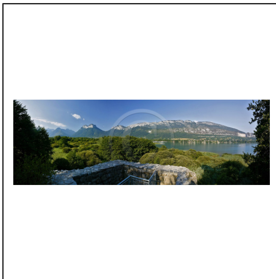
Haute-Savoie, 74, Lac d'Annecy, Doussard, Réserve naturelle du Bout du Lac, La tour médiévale de Beauvievier, menacée d'effondrement, a été restaurée et transformée en observatoire. // Haute-Savoie, 74, Lake Annecy, Doussard, Nature Reserve Bout du Lac, The medieval tower of Beauvievier, threatened with collapse, has been restored and converted into an observatory.
