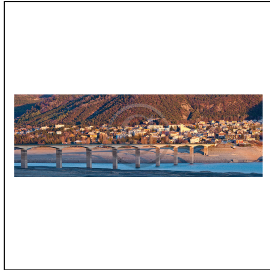
Hautes-Alpes, 05, Lac de Serre-Ponçon, Savines-le-Lac et le pont de Savines , d'une longueur de 924 mètres, relie les deux rives du lac de Serre-Ponçon. Savines, village noyé par l'établissement d'un barrage sur la Durance et la création du lac de Serre-Ponçon // Hautes-Alpes, 05, Serre-Ponçon Lake, Savines-le-Lac and Savines bridge, with a length of 924 meters, connects the two shores of the lake of Serre-Ponçon lake. Savines village drowned by the establishment of a dam on the Durance and the creation of Lake Serre-Ponçon lake.
