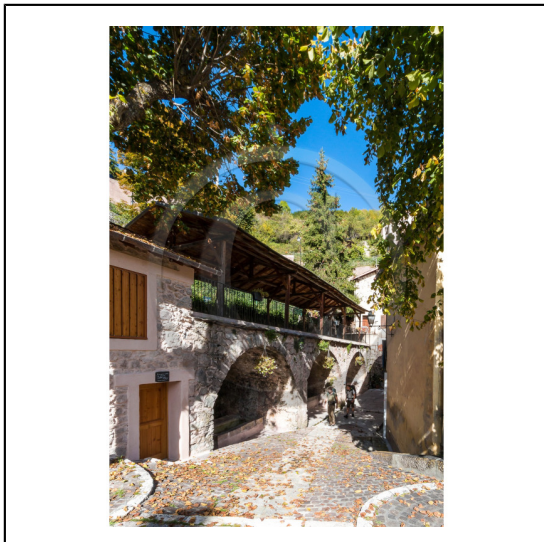
Alpes Maritimes (06), Parc national du Mercantour, vallées de la Tinée et de la Vionène, Roure, fontaine-lavoir à triple voûte de pierres, hourdées à la chaux, surmontée d'une terrasse pour étendre le linge // Alpes Maritimes (06), Mercantour national park, Tinee and Vionène valley, Roure village, fountain-washhouse to the triple arch stones hourdées with lime, is topped by a terrace for drying clothes
