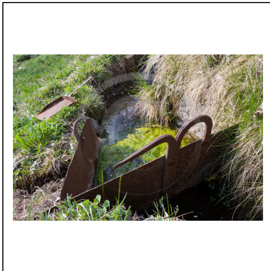
Hautes-Alpes (05), Guisane, Briançon, réseau des canaux d'irrigation du Briançonnais, canal d'irrigation, Canal Neuf, Rochas Garnier, étanche à poignée et pelle // Hautes-Alpes (05), Briançon, irrigation channels in Briançonnais, irrigation channel Rochas Garnier, channel Neuf
